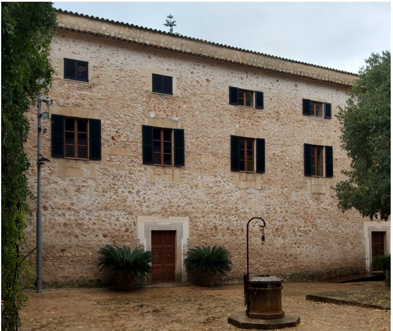
Fachada interior de la Finca Raixa, propiedad del Consell de Mallorca © ERF
